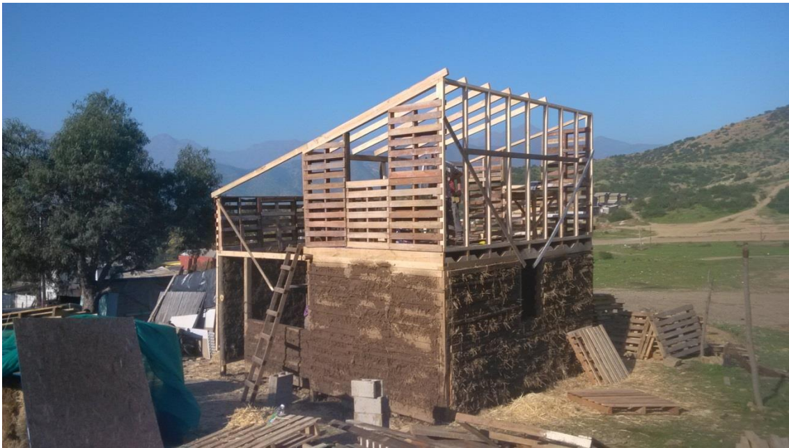
Projecte a Valparaíso (Chile) realitzat per Arquitectos Técnicos Sin Fronteras
